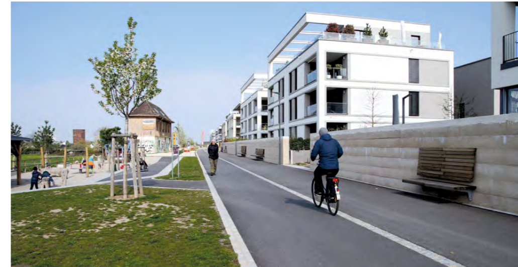
Anforderungsgerechte Radverkehrsanlage in der Bahnstadt
