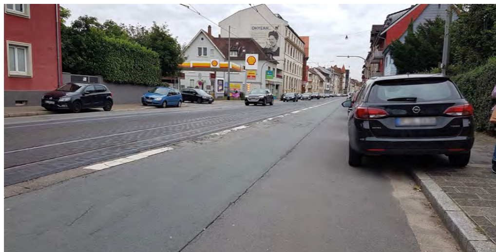
Straßenabschnitt mit hohem Handlungsbedarf (Dossenheimer Landstraße)
